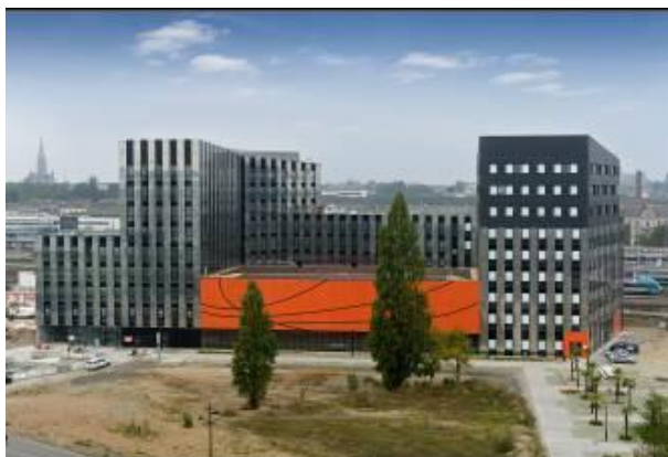
Immeuble VEO –EuroNantes
