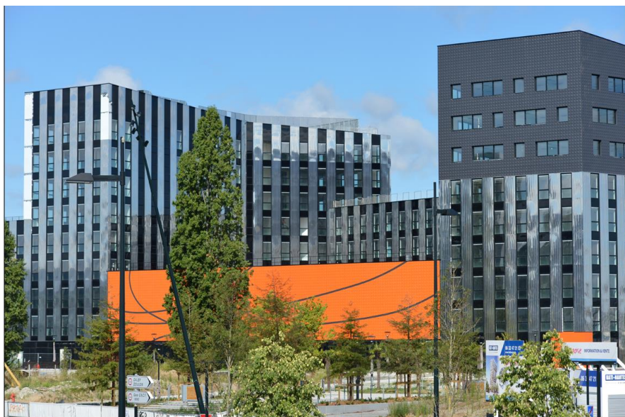
Immeuble VEO – Nantes – quartier EuroNantes
